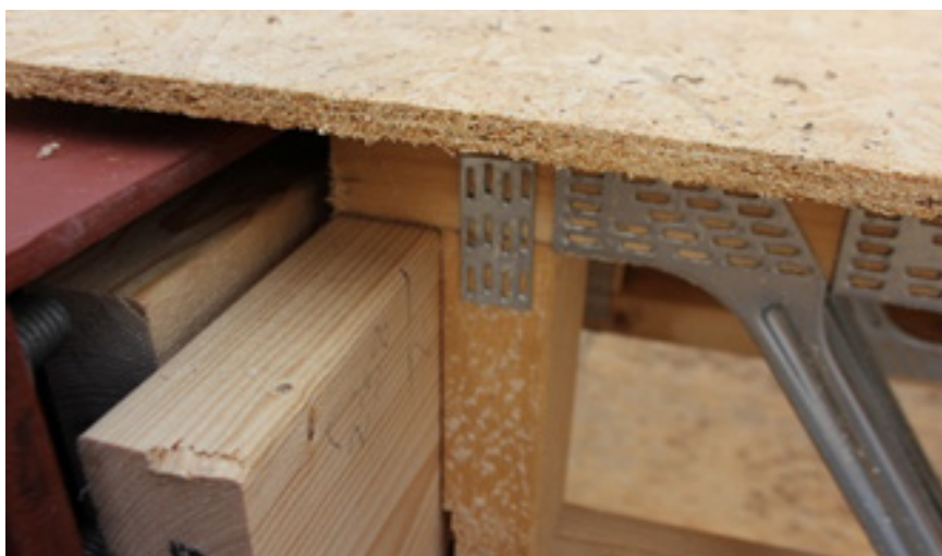
Upphängning mot stålbalk utan balkskor.
