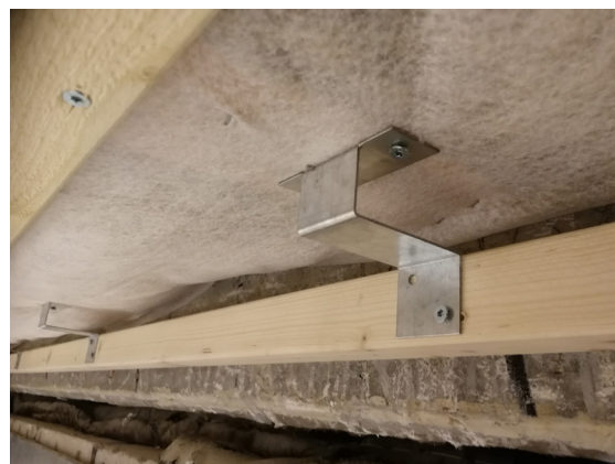
Ljudprofil monterad på detta vis har efter tester visat ge den bästa vibrationsdämpningen, enligt uppmätningar med *japanska bollen*. Observera att om regeln monteras på andra sidan av ljudprofilen (kontakt på två sidor) ger detta ett sämre resultat, även fast den varianten också klarar ljudkraven.
