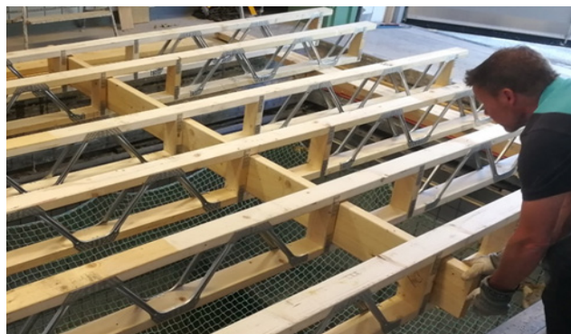
Sviktavstyvning monteras för spännvidder längre än fyra meter.
