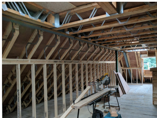
Fastplåtdad änddetalj har upplag på hammarband.
