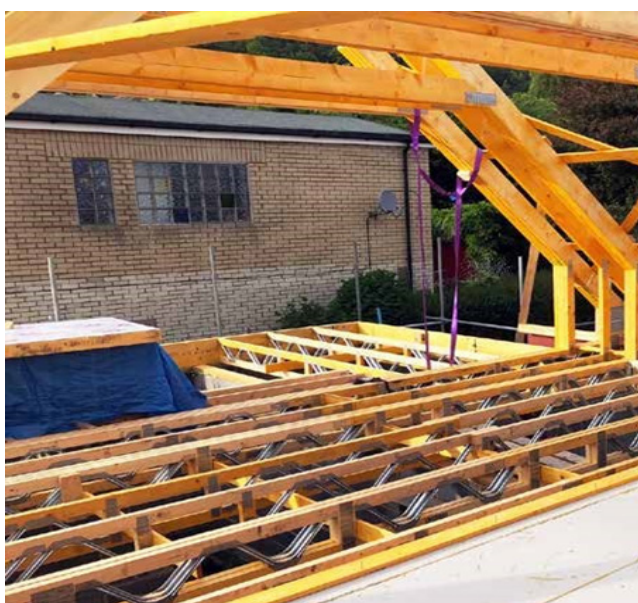
Posi-ramverk på byggsplats.
