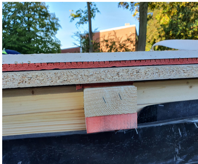
Vi ser en vibrationsdämpare fastlimmad på Posi-Joistens överram.
