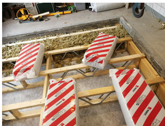
Isolering med lösull kan göras redan i fabrik för en kassetten, eller på byggplats.
